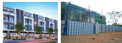
Công trường dự án Metro Valley.
